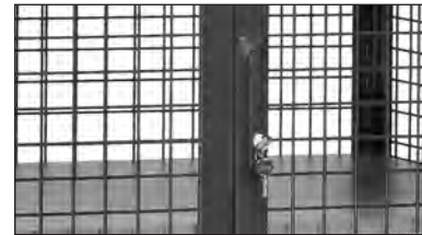
Treibriegelverschluss mit Schwenkhebel und Zylinderschloss.
